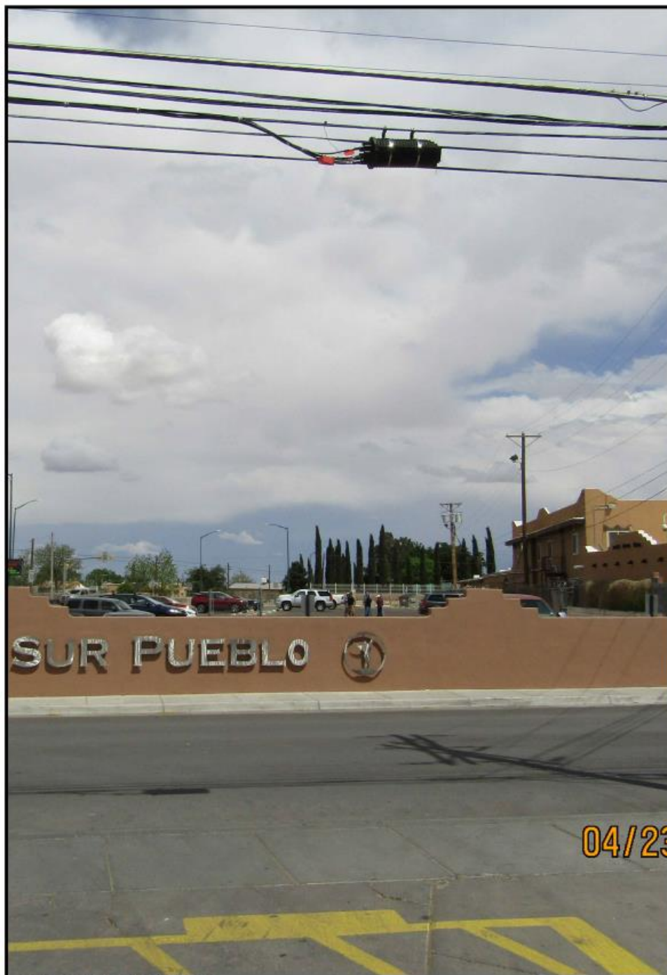
1 EXISTING SITE PHOTO SCALE: N.T.S.
