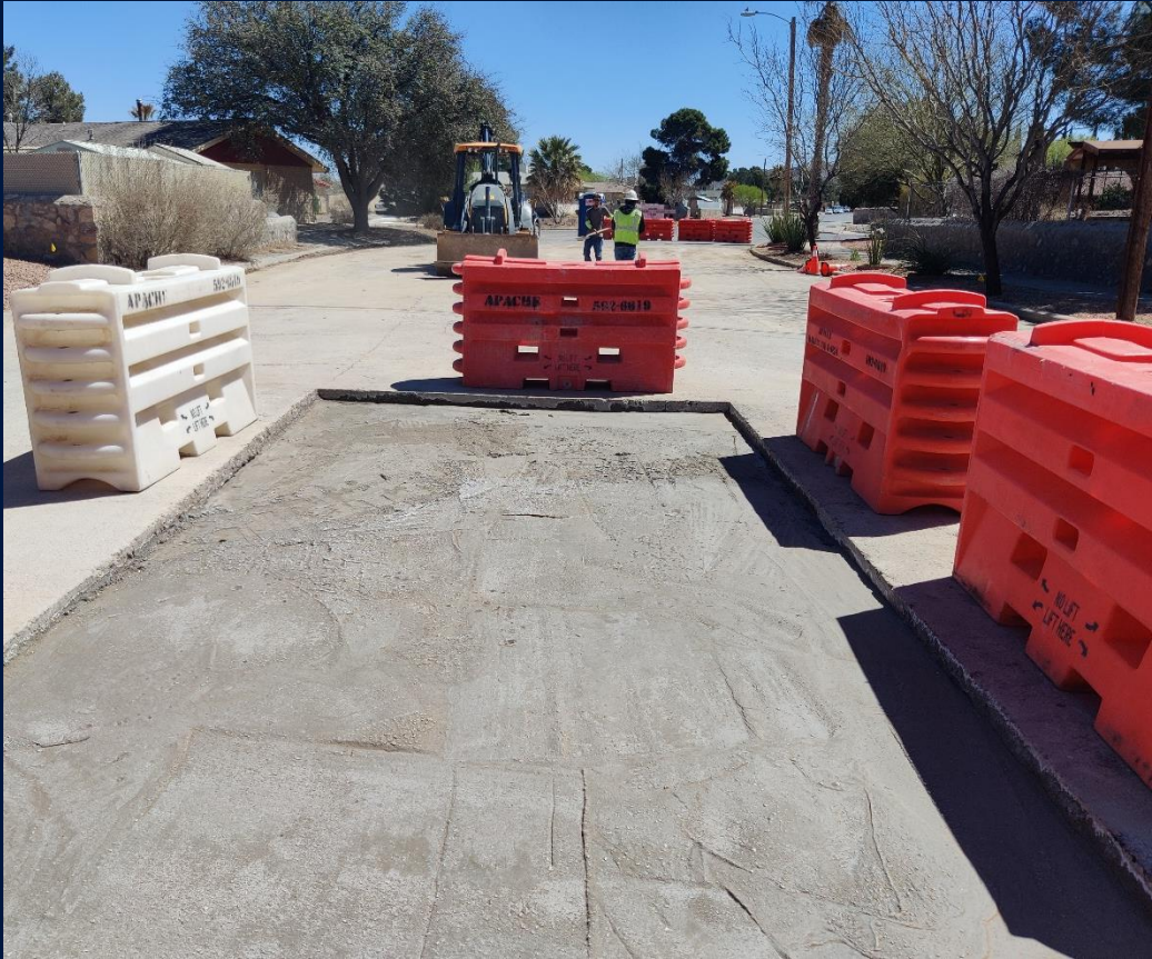
Conduit Repair
